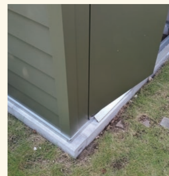
緑石ブロック上に設置
